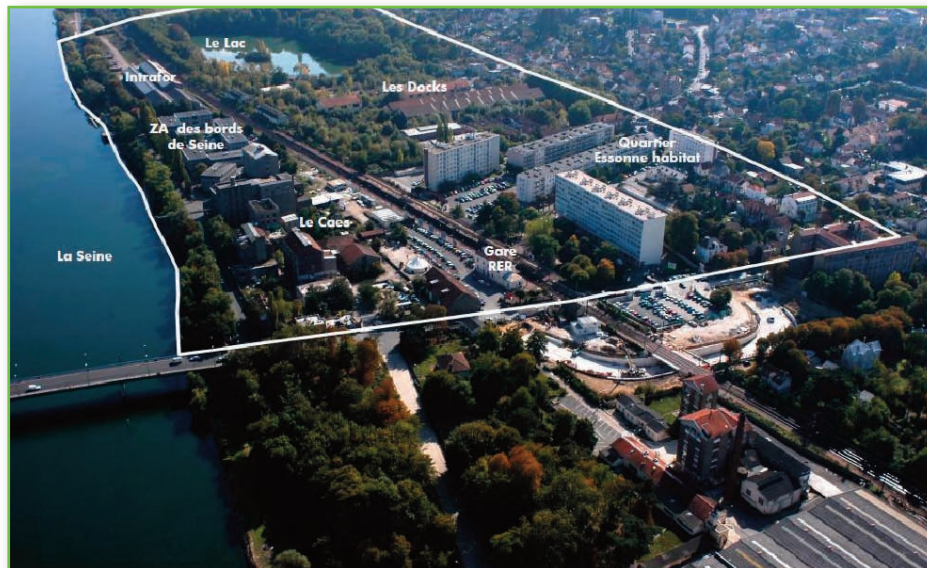
Vue aérienne des Docks de Ris
