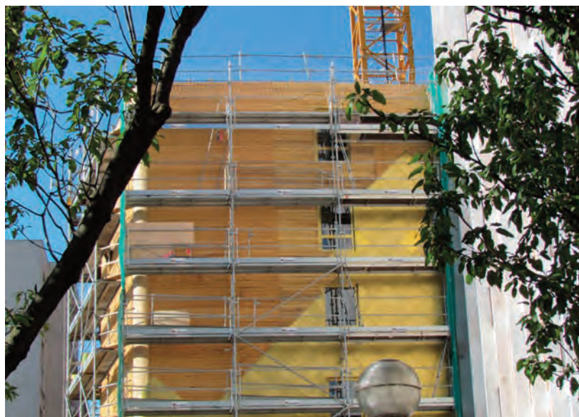
Isolation thermique par l'extérieur
