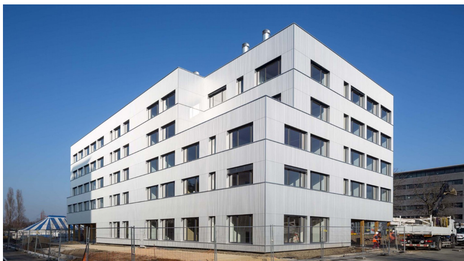
bâtiment Max Weber à Nanterre, photo © Hervé Abbadie - Architecte Pascal Gontier - Maître d'ouvrage : Université Paris Nanterre
